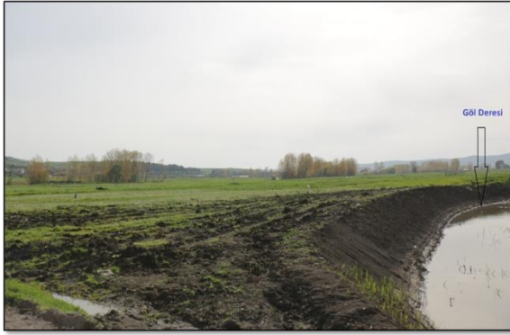
Foto 10. Göl Dere Taşkın Yatağının Görünümü
